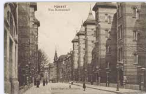
Immeubles rue Rodenbach (Forest), 1903, arch. C. DE QUÉKER et A. HANNAERT.
