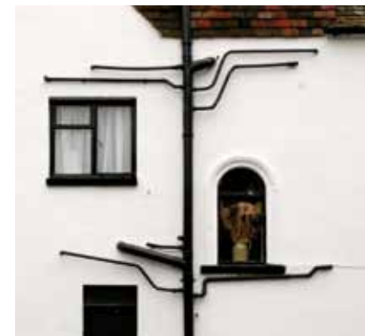
Voorbeeld van een niet-conforme installatie.
